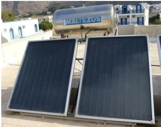
Termotanque solar para agua caliente
