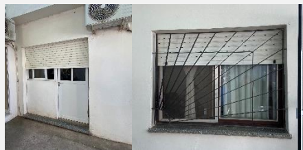
Fachada Oeste (Ventana/muro= 20%)
