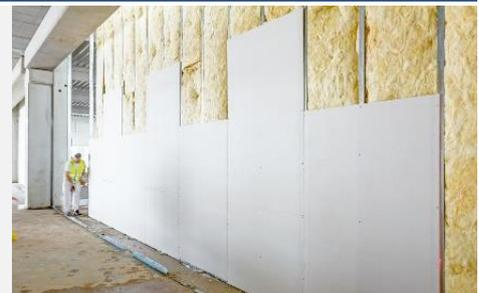
Ejemplo aislamiento térmico de muros
