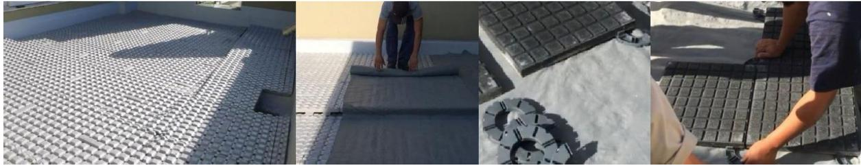
Las rejillas de los embudos pluviales quedarán expuestas para permitir su limpieza y mantenimiento. Se rodearán con las baldosas.
