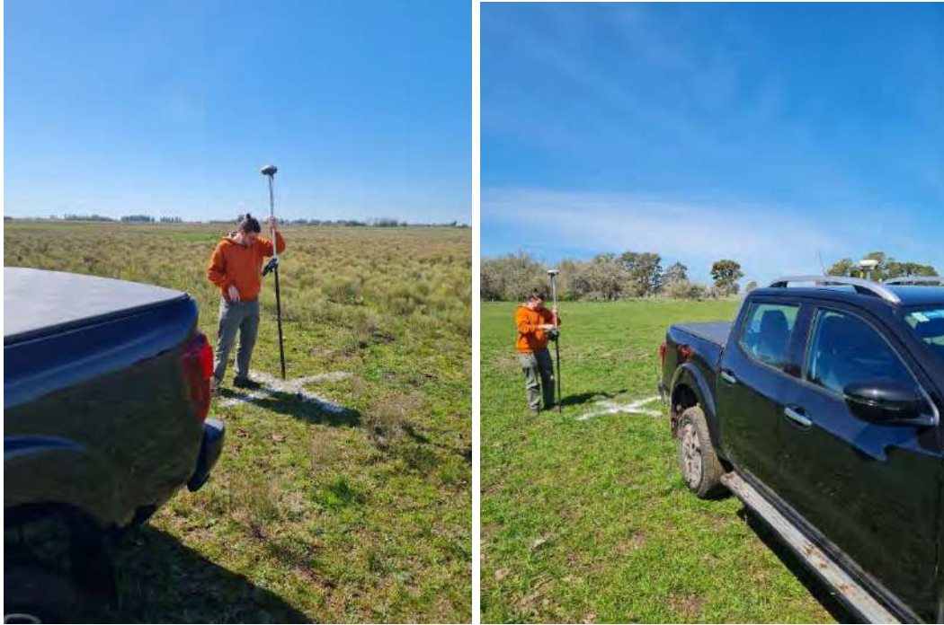
Ilustración 3 - Colocación y relevamiento de PAF.
