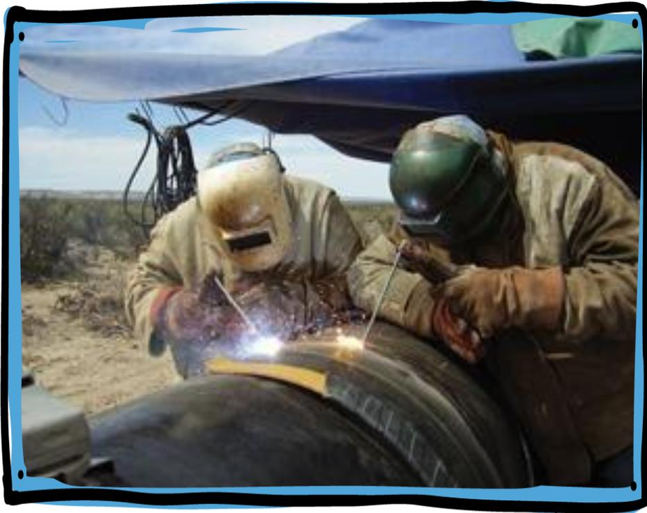
El arco eléctrico produce una temperatura de aproximadamente  $3500^{\circ}\text{C}$  en la punta del electrodo, superior a la necesaria para fundir la mayoría de los metales. El calor funde el metal base y el electrodo revestido; de esta manera, se genera una pileta líquida o baño de fusión que se va solidificando a medida que el electrodo se mueve a lo largo de la junta.
